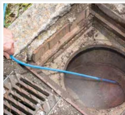
Fig. Tubo flessibile per la pulizia di tubazioni
